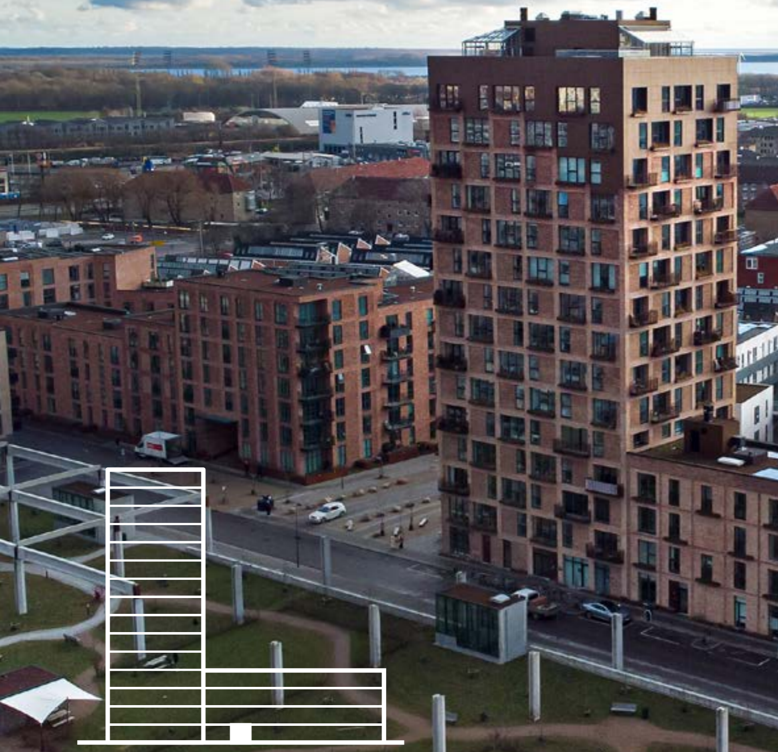
Figur 46: Amaryllis Hus ligger på Grønttorvet i Valby. Bebyggelsen består af tårnet og en boliglænge på 4, 5 og 6 etager. I planen for Grønttorvet er der lagt stor vægt på det grønne og på fællesskab. Der etableres en 23.000 m 2 stor park og et fælleshus lige ved Amaryllis Hus. I selve tårnet er der ingen fælleslokaler, men på taget af længen findes en fælles tagterrasse med et væksthus, som er åben for alle i Amaryllis Hus. © Bjørn Pierrri Enevoldsen.
