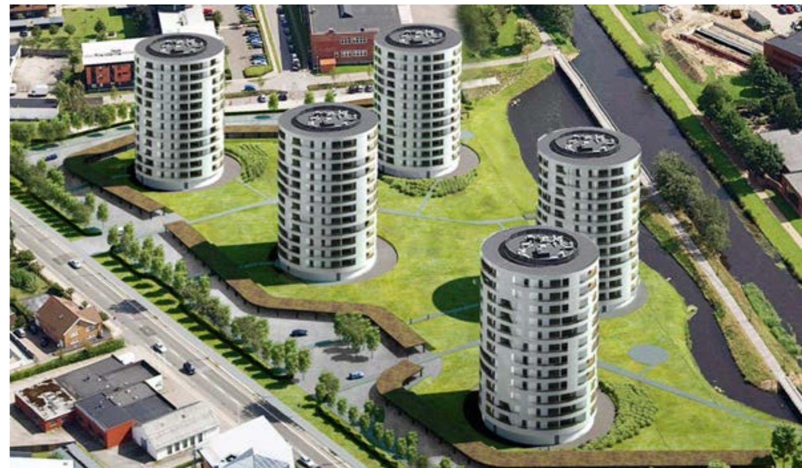
Figur 22: Parkbebyggelsen ligger mellem Sønderå, Vejle centrum og det mere åbne Adalen, som er en lille del af det område, kommunen har udpeget til udviklingsområdet Mikropolzonen. © Visualisering fra Arkitema Architects.
