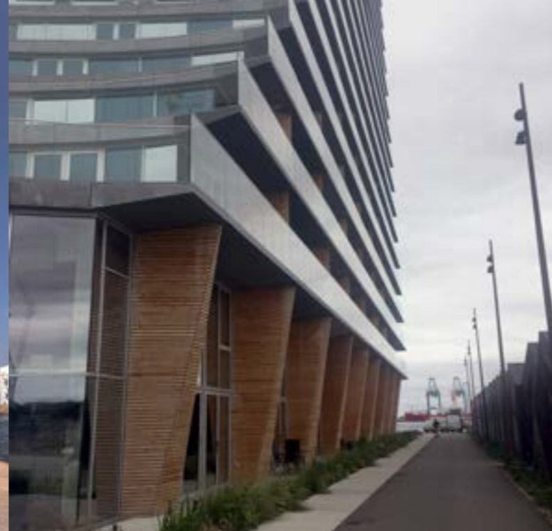
Figur 70: På tre af bebyggelsens sider (den fjerde ligger ud til den planlagte kanal) er der placeret "aktivitetshuse" i to etages højde med glasfacader. De er adskilt af de lodrette, gennemgående trækonstruktioner. Hensigten er at skabe en gadestemning. Billedet viser siden ud mod badehusene og havnebadet, hvor beboerhuset ligeledes er placeret. © BUILD/Hauxner.
