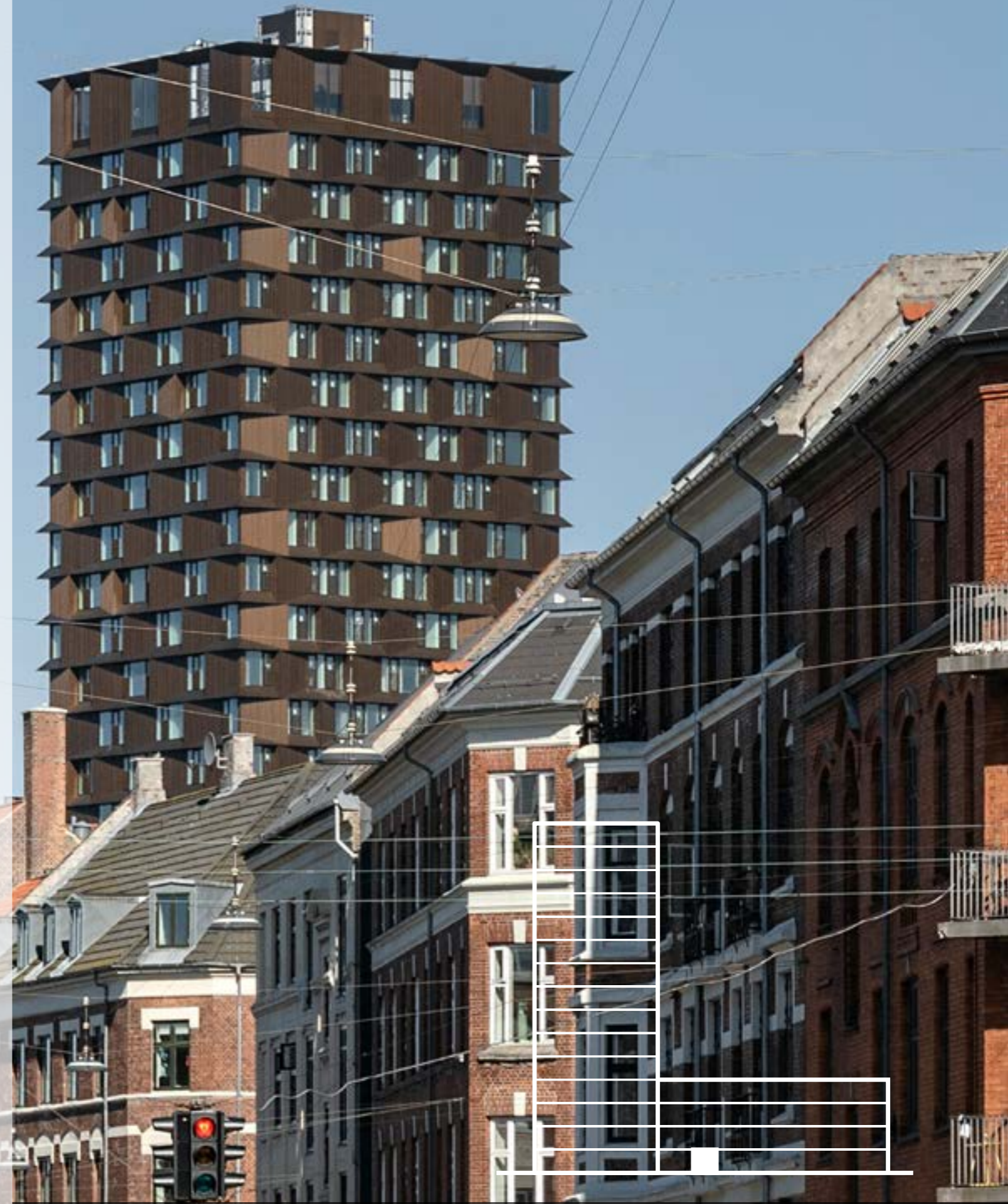
Figur 58: Nordbro ligger i et urbant og trafikeret område med meget byliv på Ydre Nørrebro i København. Byggeriet, som er af typen højhus på boliglænge/karré, består af et 100 meter højt tårn på 30 etager og seks punkthuse placeret rundt om en sammenhængende bebyggelse med bil- og cykelparkering og et indre gårdrum. Tårnet kan ses på lang afstand, har en unik udsigt over byen, og på tårnets 30. etage findes en udsigtsplatform med offentlig adgang. © Foto: Arkitema Architects - Jens Lindhe.
