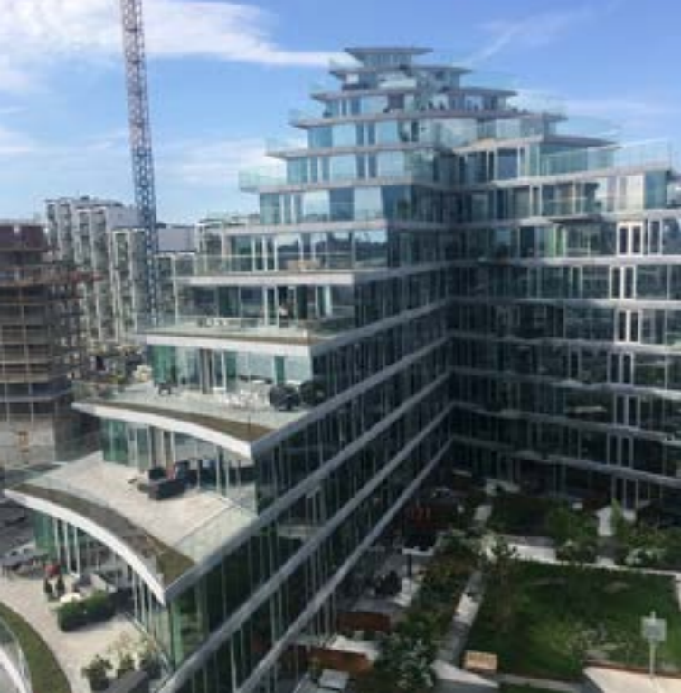
Figur 67: Gårdrummet fra 8. etage. Her kan man se, hvordan de private terrasser er placeret i bjergformation fra gårdrummet, der ligger på 2. etage og op til bygningens nordlige tårn på 12. etage. © BUILD/Hauxner.
